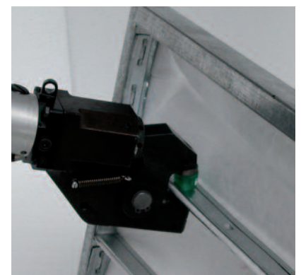
Trappe de ventilation
